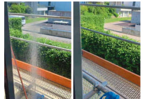
/ Vorher/nachher: Auch chemische Oberflächenschäden z. B. durch Zement können instand gesetzt werden.
